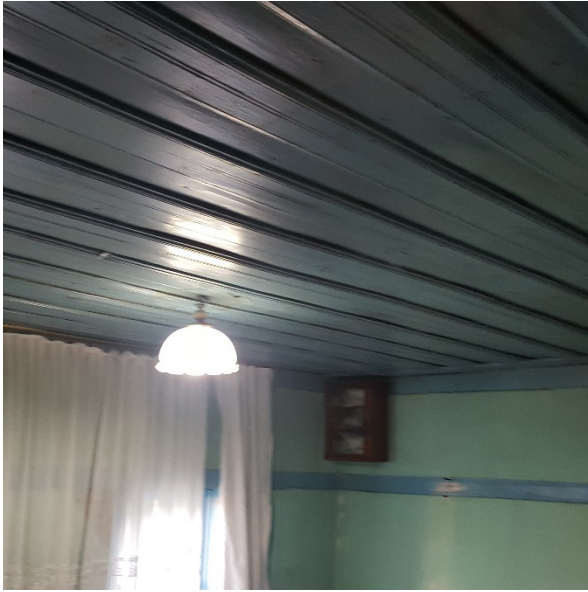
Şekil 28. Alioğlu Köyü-Ahşap tavan kaplaması.
