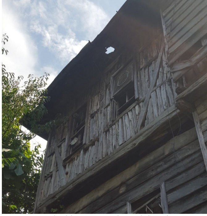
Şekil 6. Büyüktekke Köyü- Ahşap dolgu sistem yapısı .
