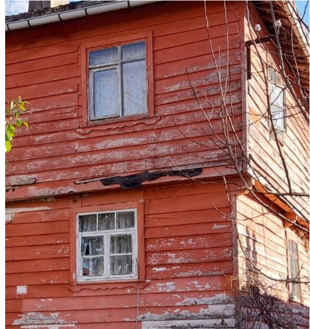
Şekil 3. Alaplı Okçular Köyü ahşap yapı
