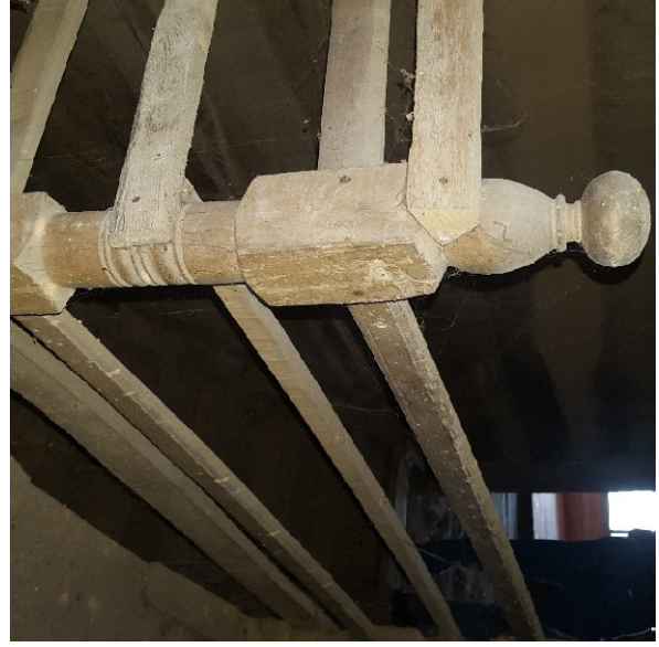
Şekil 24. Ahiler Köyü –Ahşap korkuluk.
