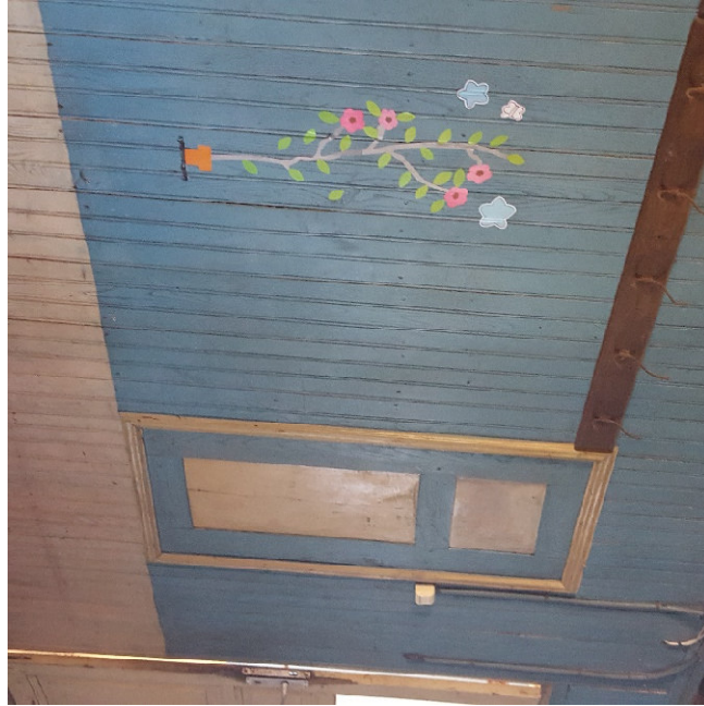
Şekil 25 .Alioğlu Köyü –Ahşap duvar kaplama detayı.
