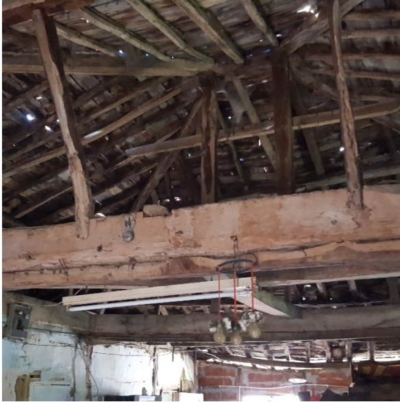
Şekil 18. Alioğlu Köyü-Konut çatı detayı.
